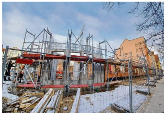
Die Rundung soll der optische Hingucker des Gebäudes werden. Im Erdgeschoss wurde diese in den vergangenen Wochen eingeschalt und gegossen.
