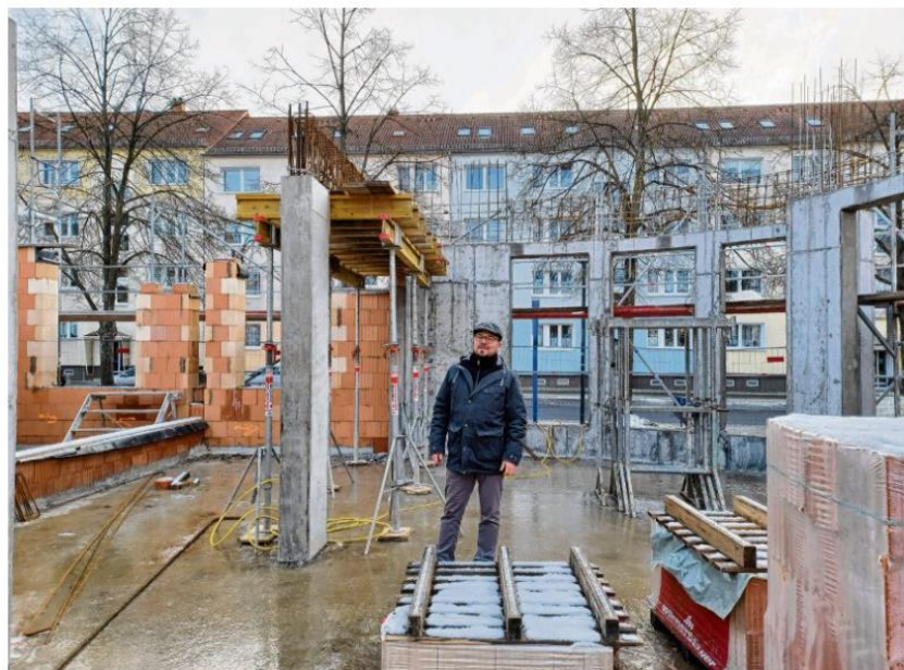
Das Erdgeschoss in der Keilstraße steht bereits zu großen Teilen, wie WGA-Chef Falko Jonas zeigt.
